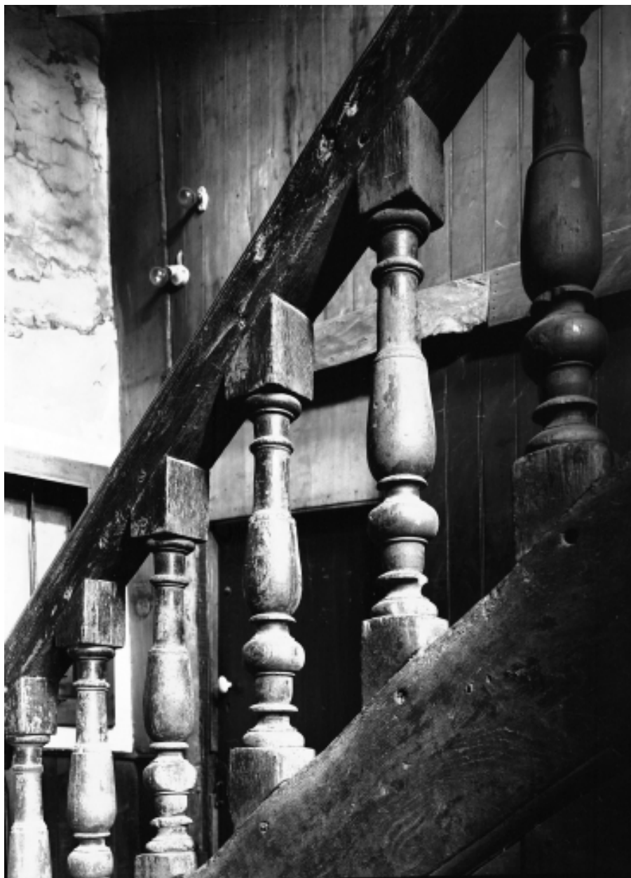
Escalier : rampe à balustres, détail
