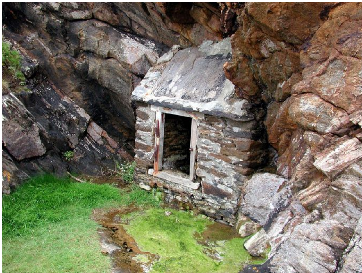
Vue de l'aiguade de la pointe de Kermorvan, petit édifice en maçonnerie abritant la fontaine
