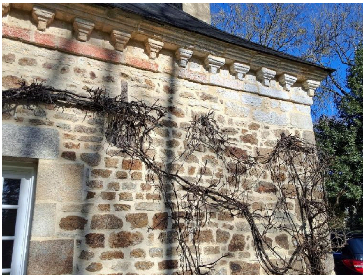
Dépendances, détail : corniche et bandeau rougeâtre en saillie
