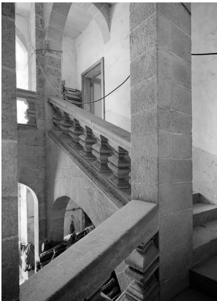
Cage d'escalier, 1er demi-niveau, état en 1967
