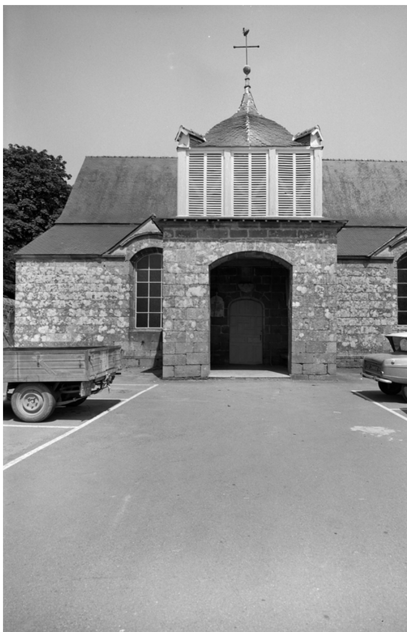
Façade sud, porche : face sud
