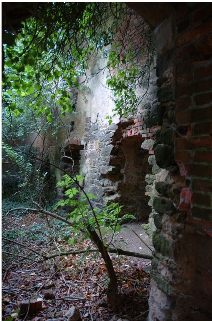
Vue de la caserne (état en 2007)
