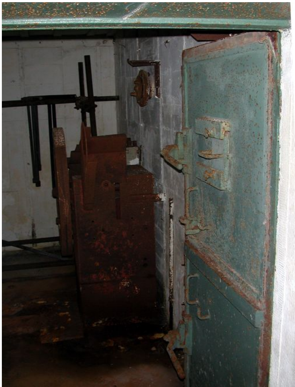
Vue intérieure : porte blindée à deux vantaux et équipements (état en 2003)
