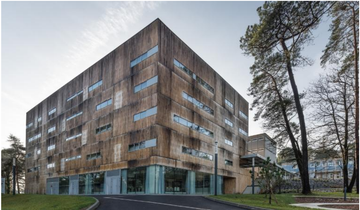
Nouvel internat (2018), David Cras, architecte. Vue d'ensemble prise depuis le nord.
