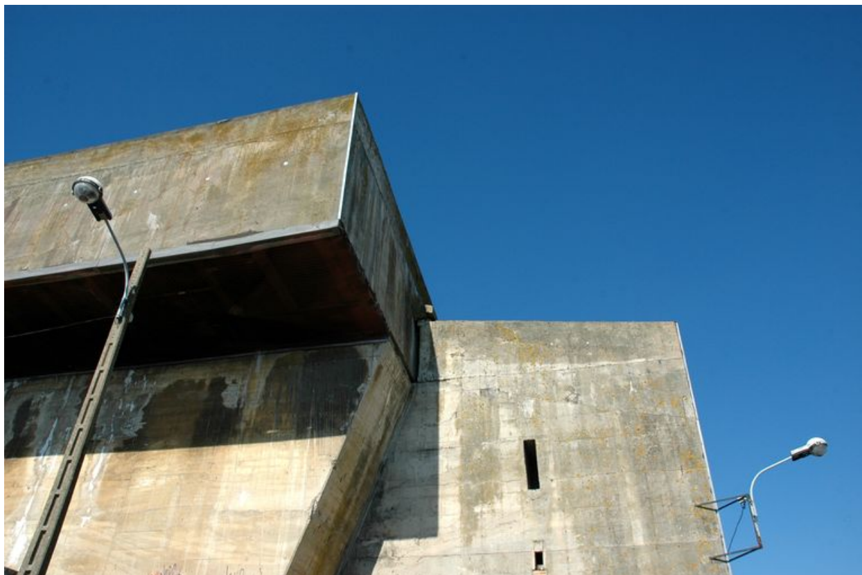
Vue de l'angle est du bunker KIII : à droite, l'extension nord-est (état en 2005)
