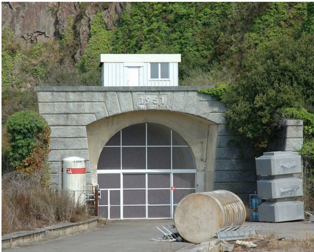
Vue générale de l'entrée souterraine : elle porte le millésime 1951
