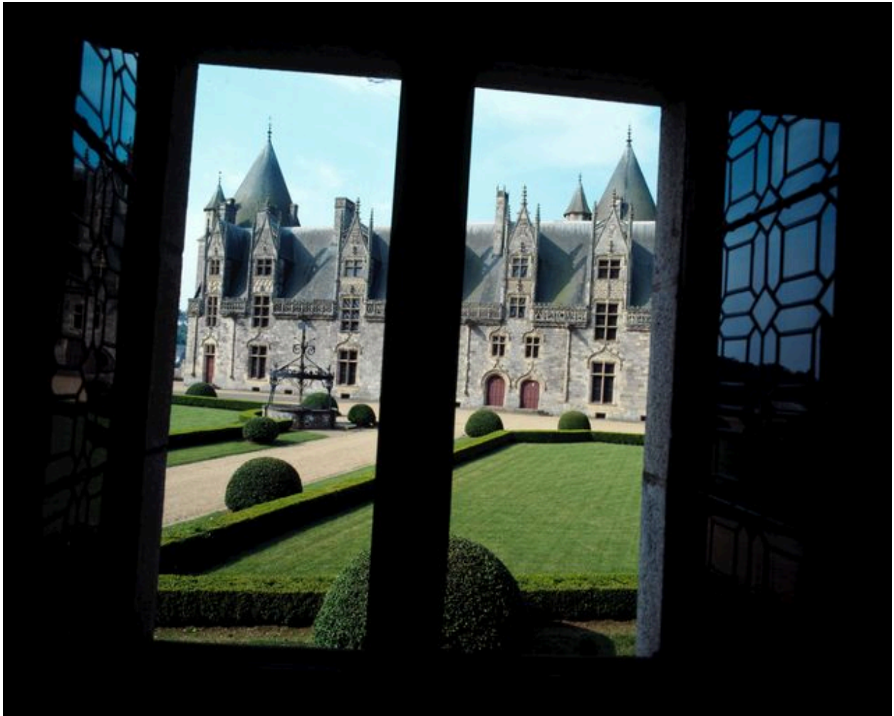
Logis, élévation sur cour : partie sud prise à partir de la tour isolée
