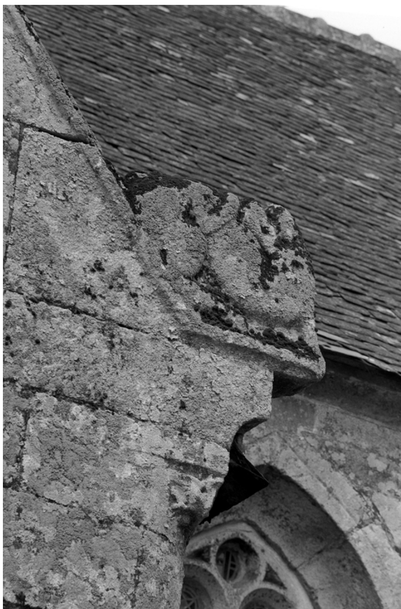
Porche sud, détail de la pierre d'assise sculptée du rampant est
