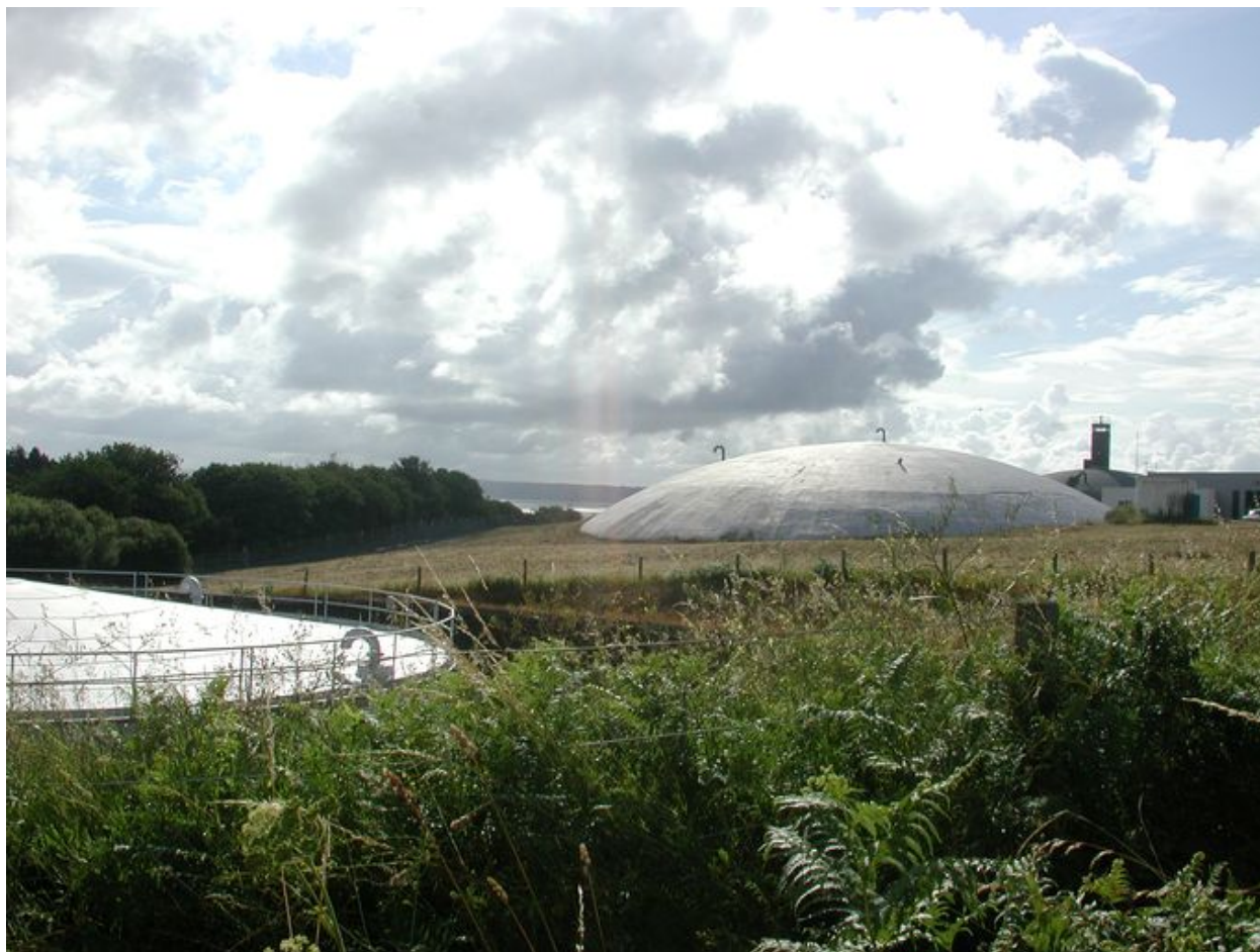
Vue générale du parc à carburant de Maison Blanche : cuve couverte
