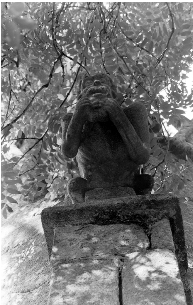
Contrefort sud-est du chevet : vue de détail de la gargouille
