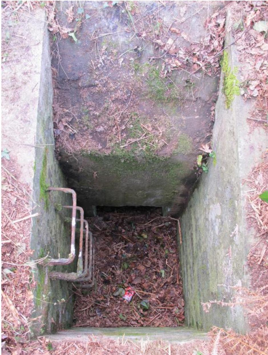
Vue du puits de la sortie de secours avec ses échelons (état en 2013)
