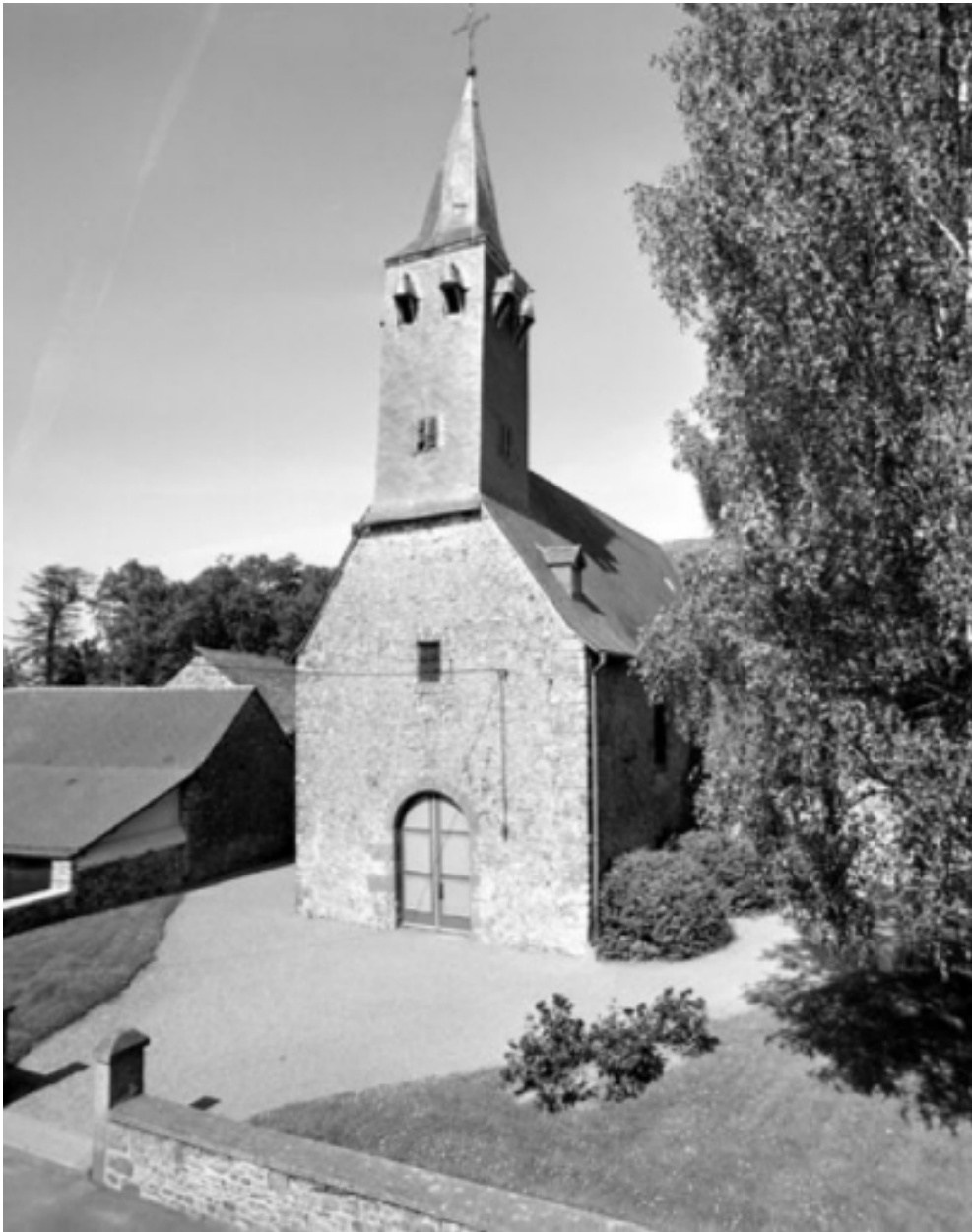
Elévation ouest : vue générale
