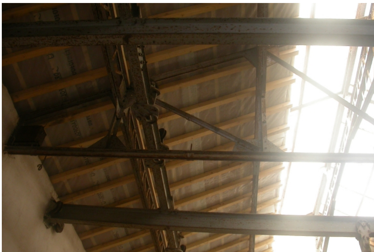
Détail de la charpente
