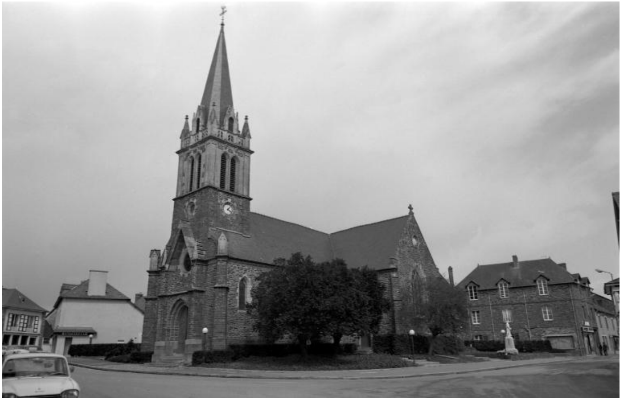
Eglise paroissiale - Vue générale sud ouest
