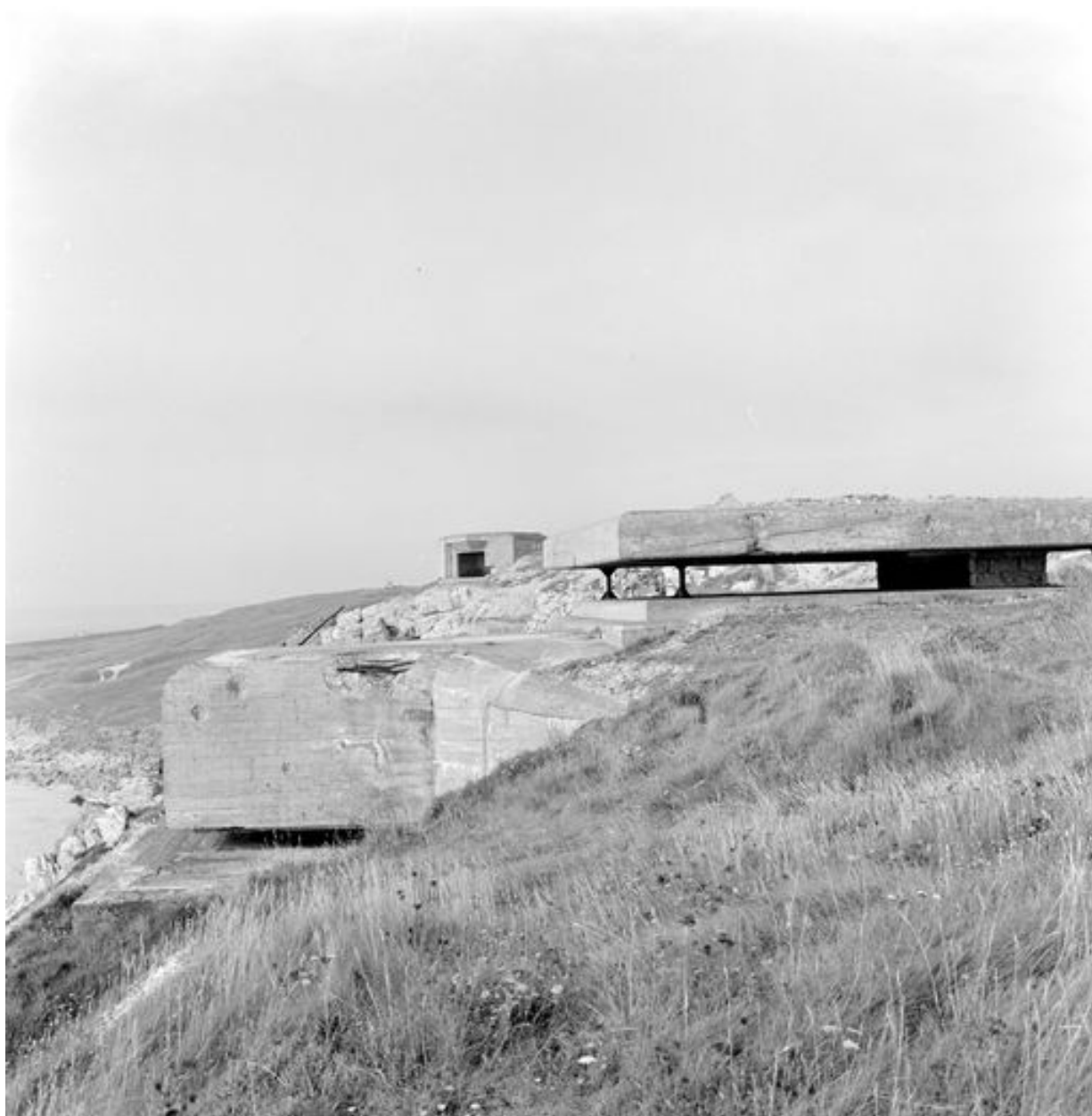
Vue de la batterie de Kerbonn en 1969 : observatoires du bunker - poste de direction de tir de type M162a. En arrière-plan : bunker - casemate pour canon de 164,7 mm
