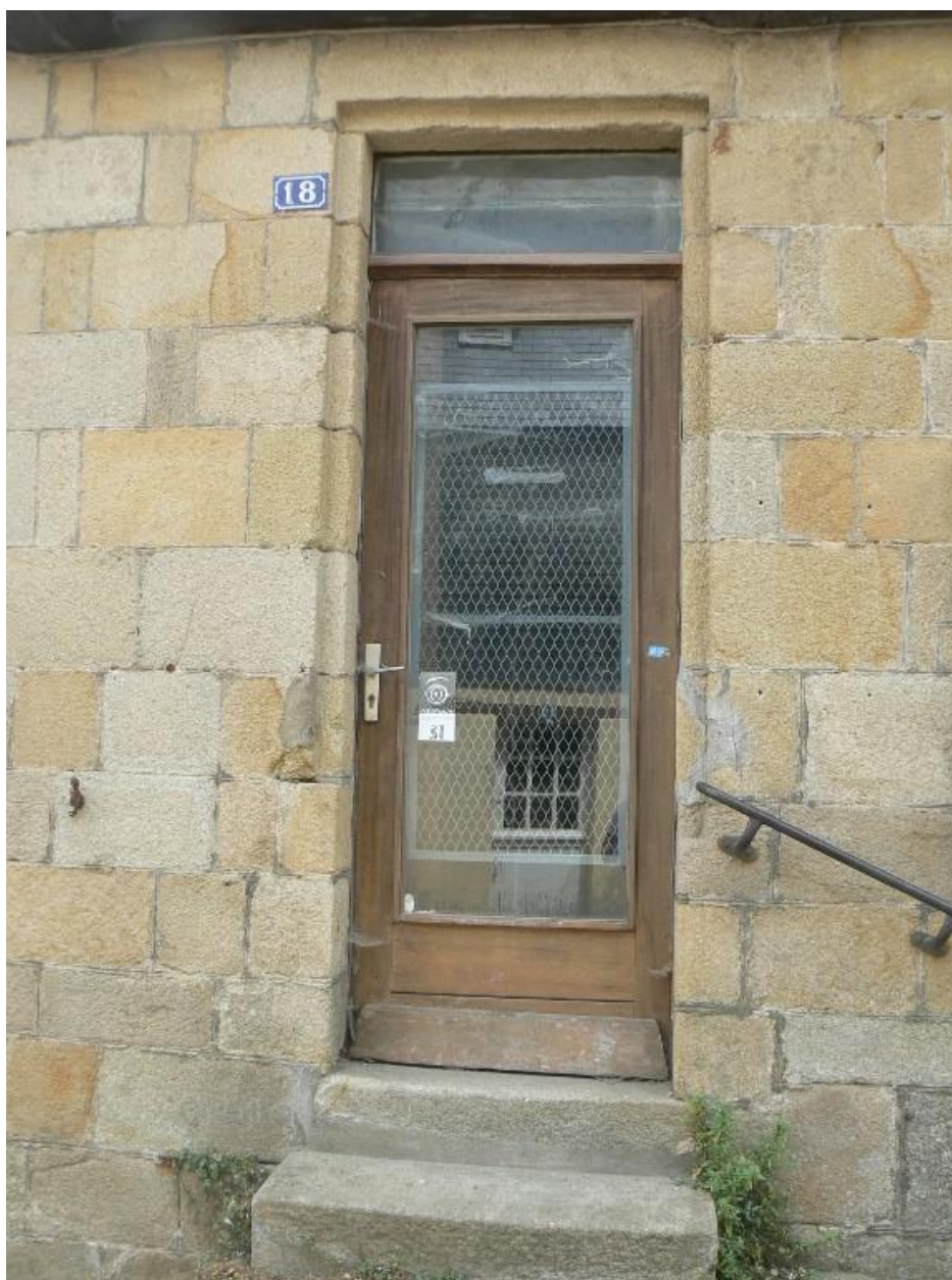
Détail d'une ancienne fenêtre transformée en porte.
