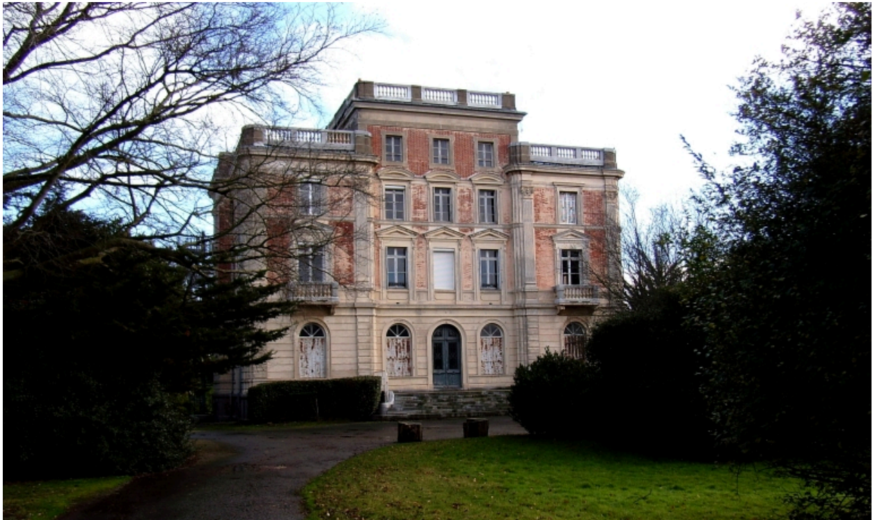
Elévation antérieure : vue générale
