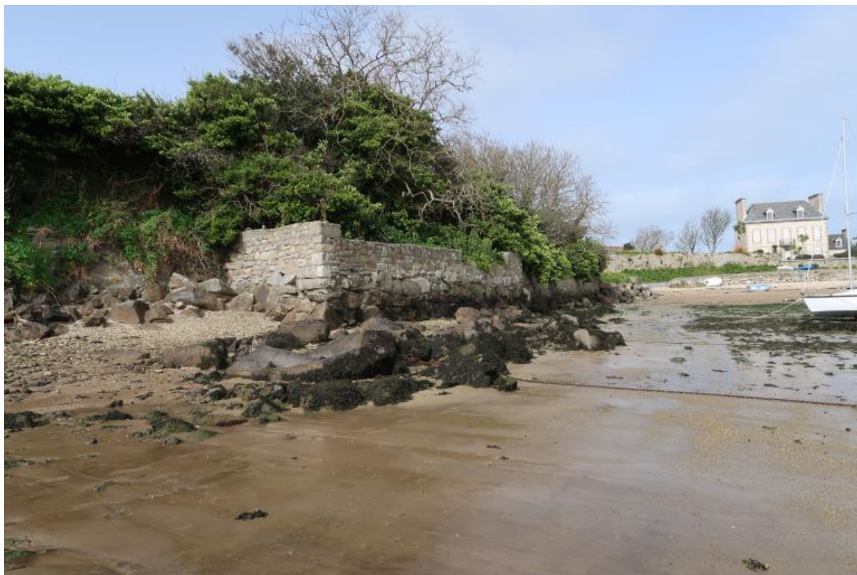
Pors an eog, murs de soutènement
