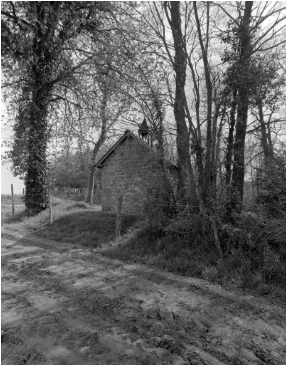
Elévation Est : vue générale
