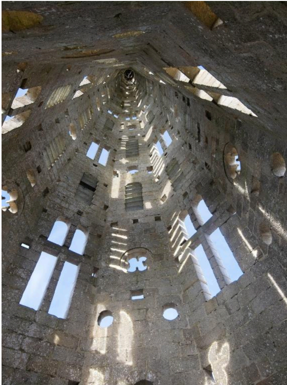
Détail de la flèche de la tour des Cloches
