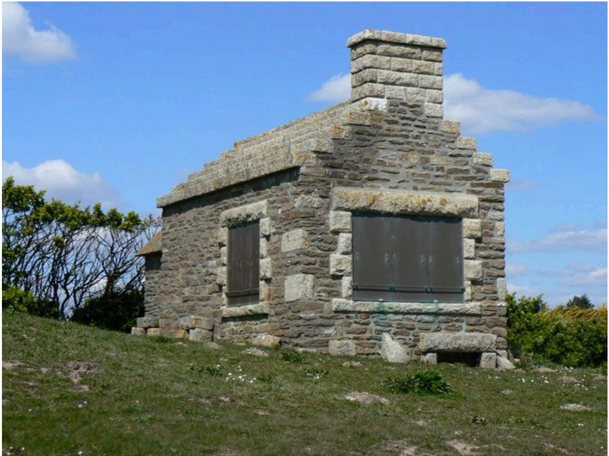
Pignon sud et façade ouest du corps de garde de Bellangenêt
