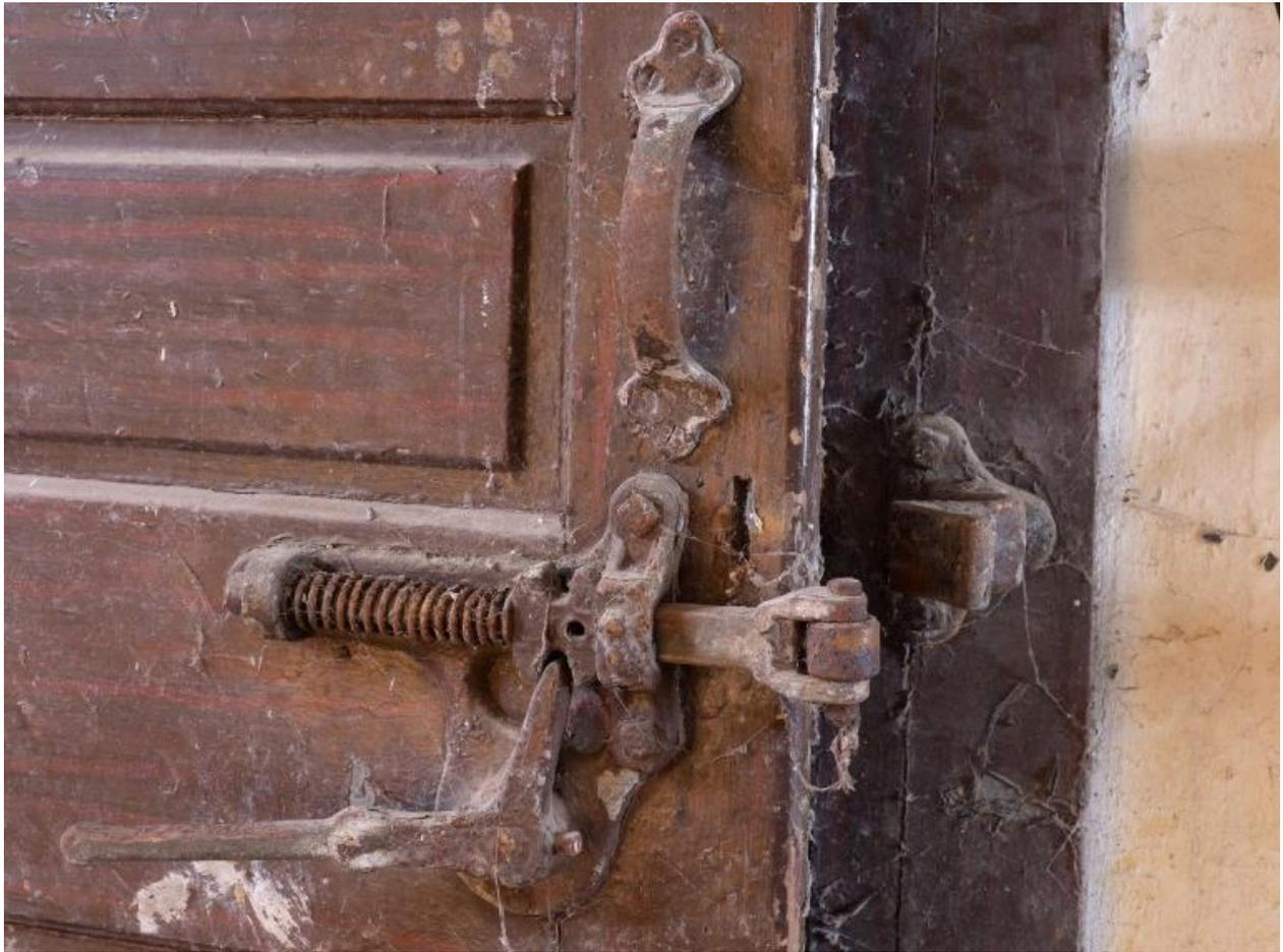
Système de fermeture des chambres froides (détail)
