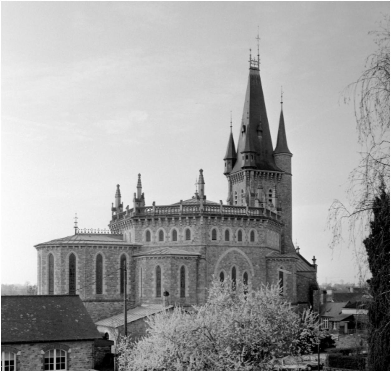
Elévation Nord-Est : vue générale
