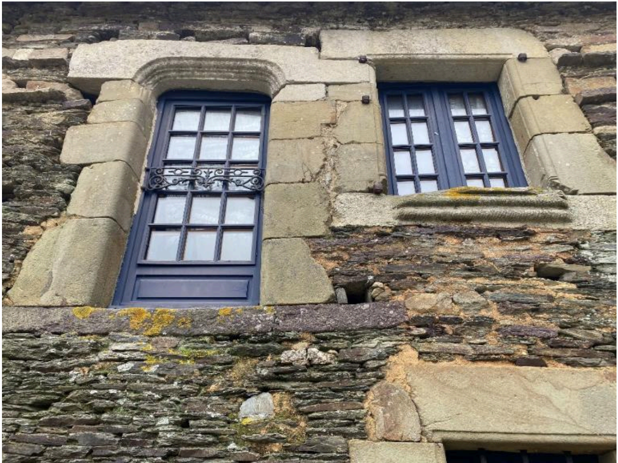
Aile nord, élévation sud, détail
