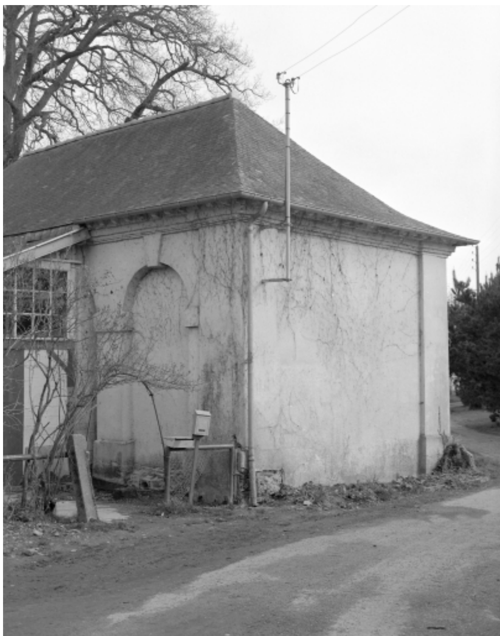
Pavillon d'entrée ; détail
