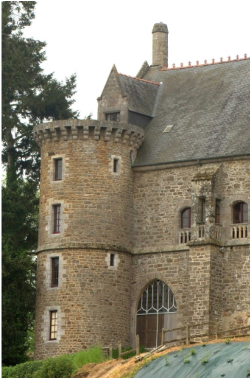
Château, façade donnant sur la Rance, détail
