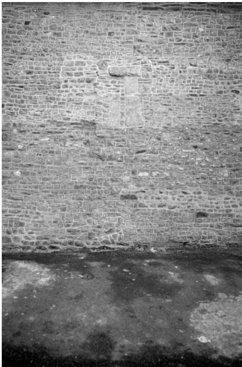
Façade Nord, nef, détail des reprises.
