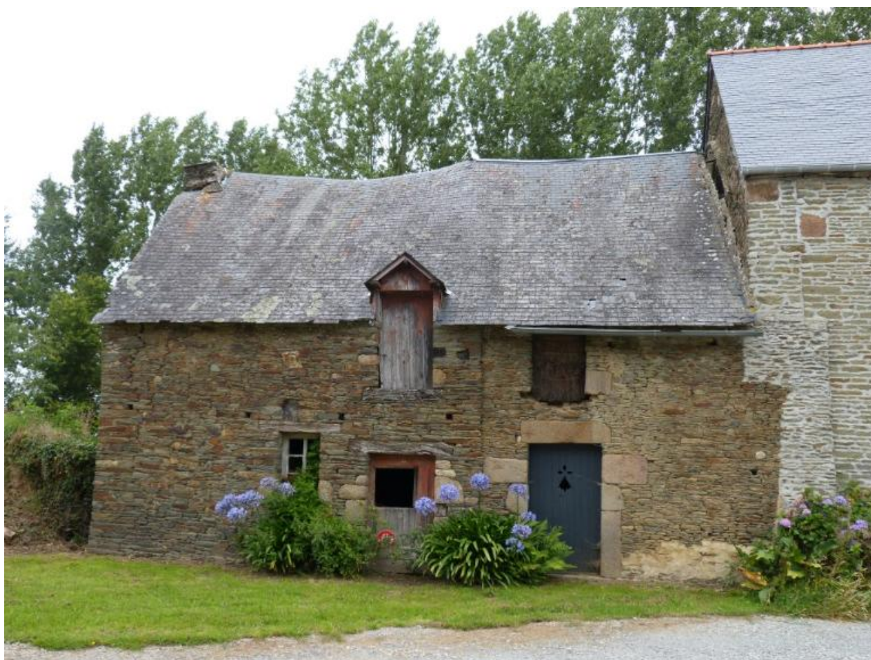
Maison - Façade principale orientée sud
