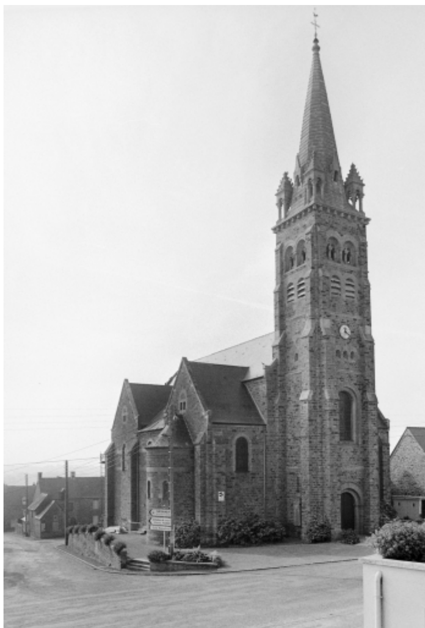
Elévation nord-est : vue générale
