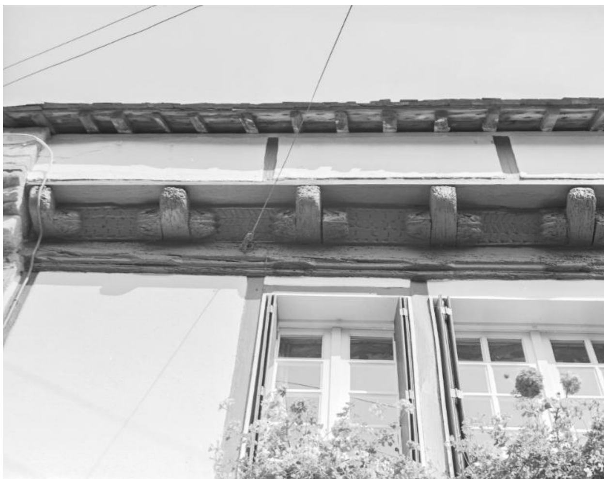
Entretoises de l'encorbellement supérieur à décor sculpté : partie gauche.
