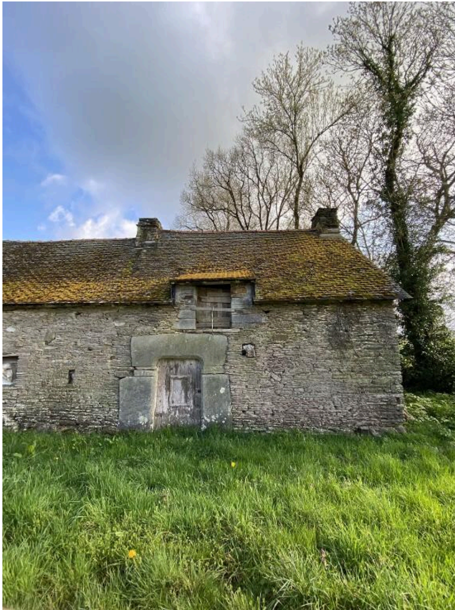
Vue générale, élévation nord. (état en mars 2025)
