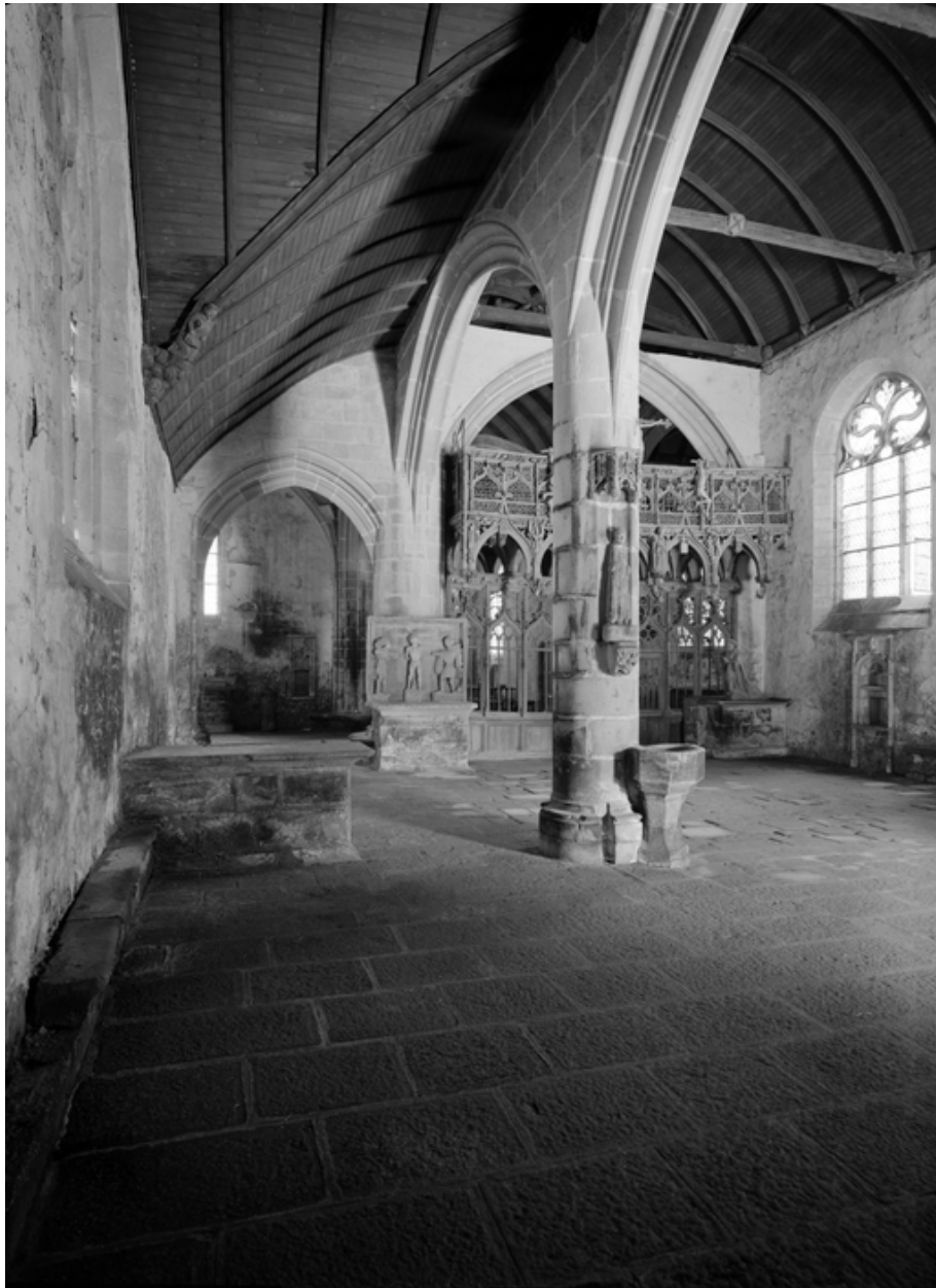
Vue générale du bas-côté nord vers l'est.
