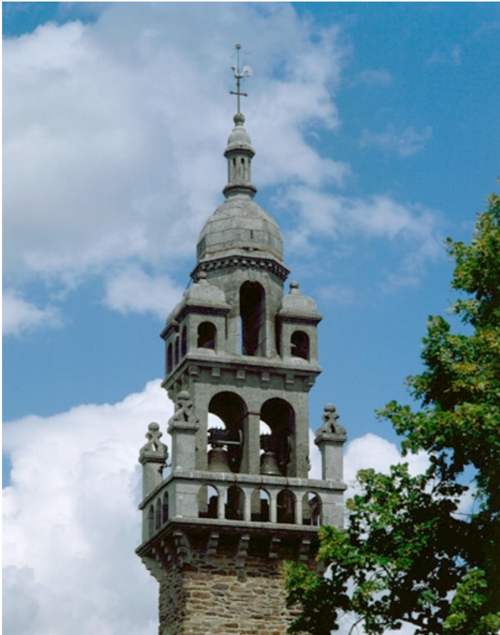
Élévation nord, clocher, partie haute : vue générale
