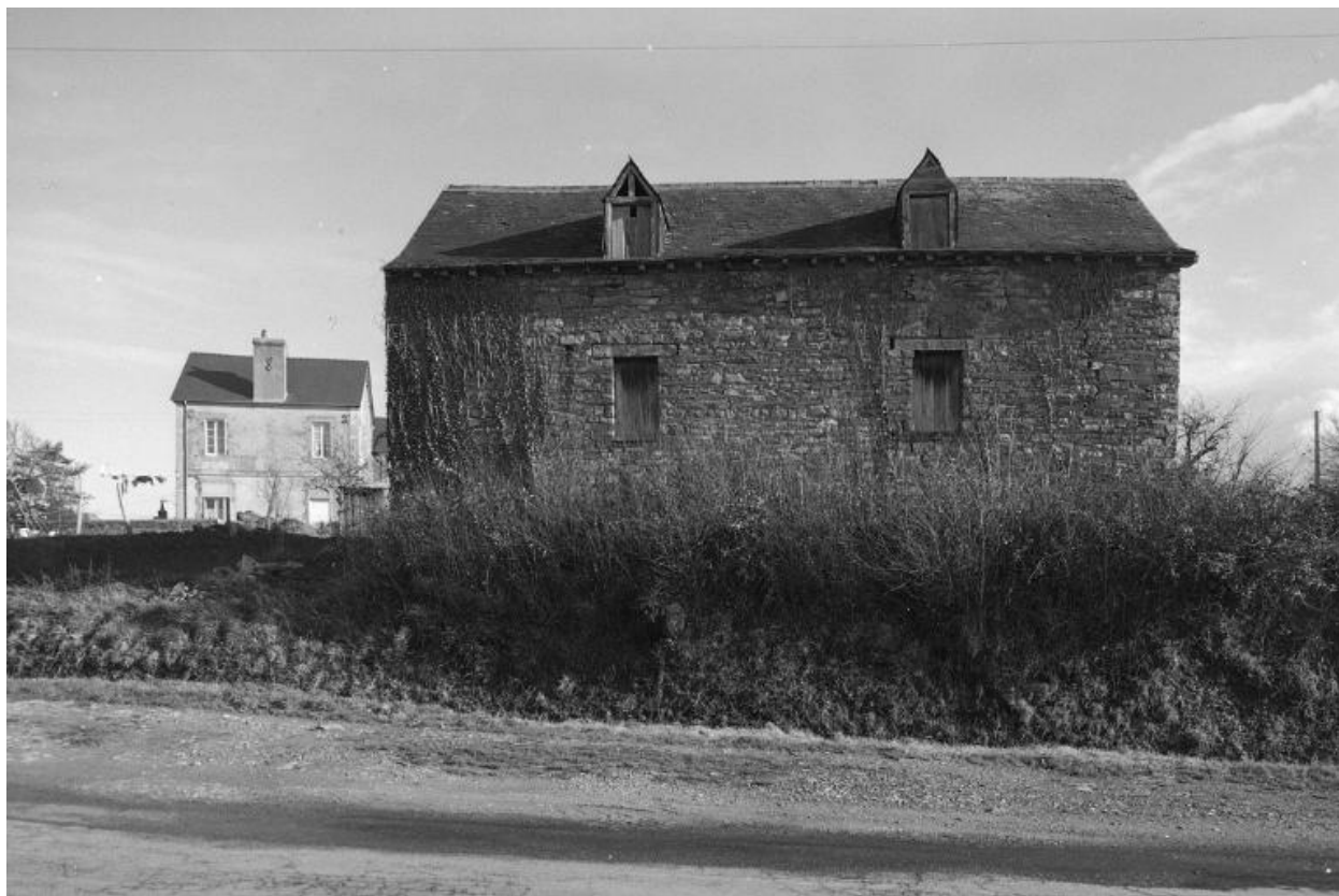
Façade ouest de la maison du 2 rue de la Mairie, avant réhabilitation
