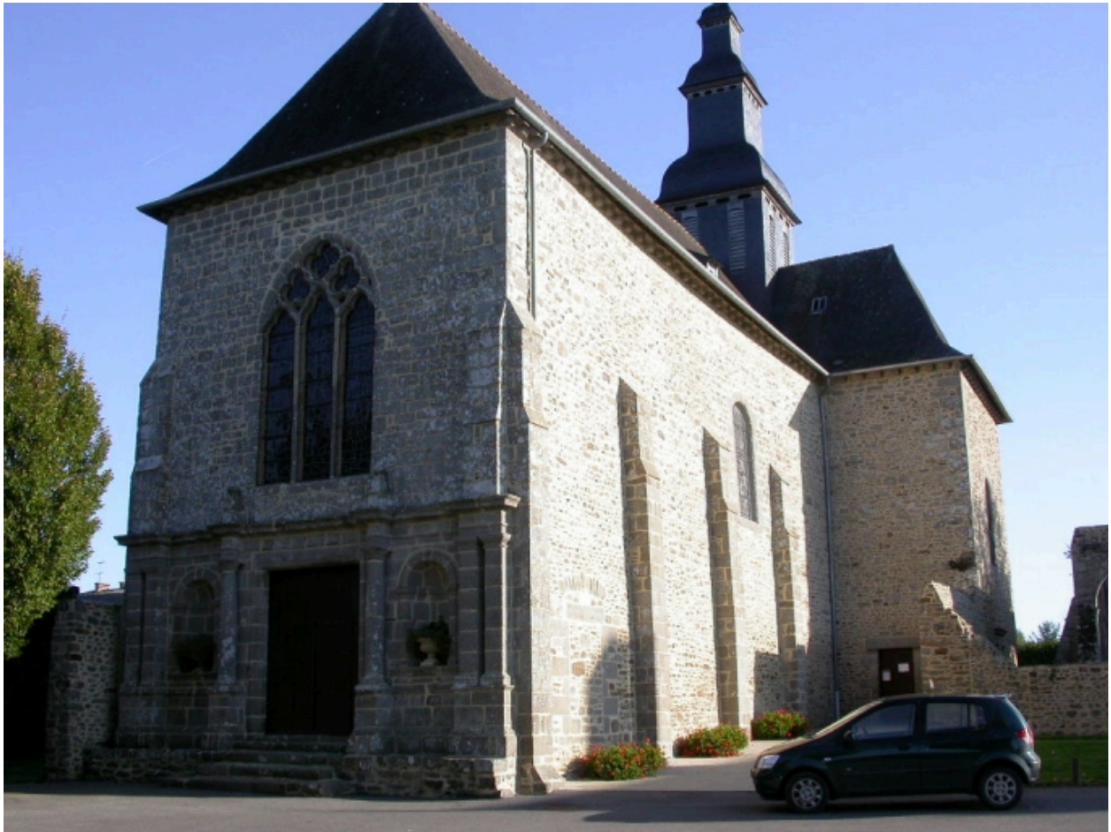
Vus sud-ouest de l'église
