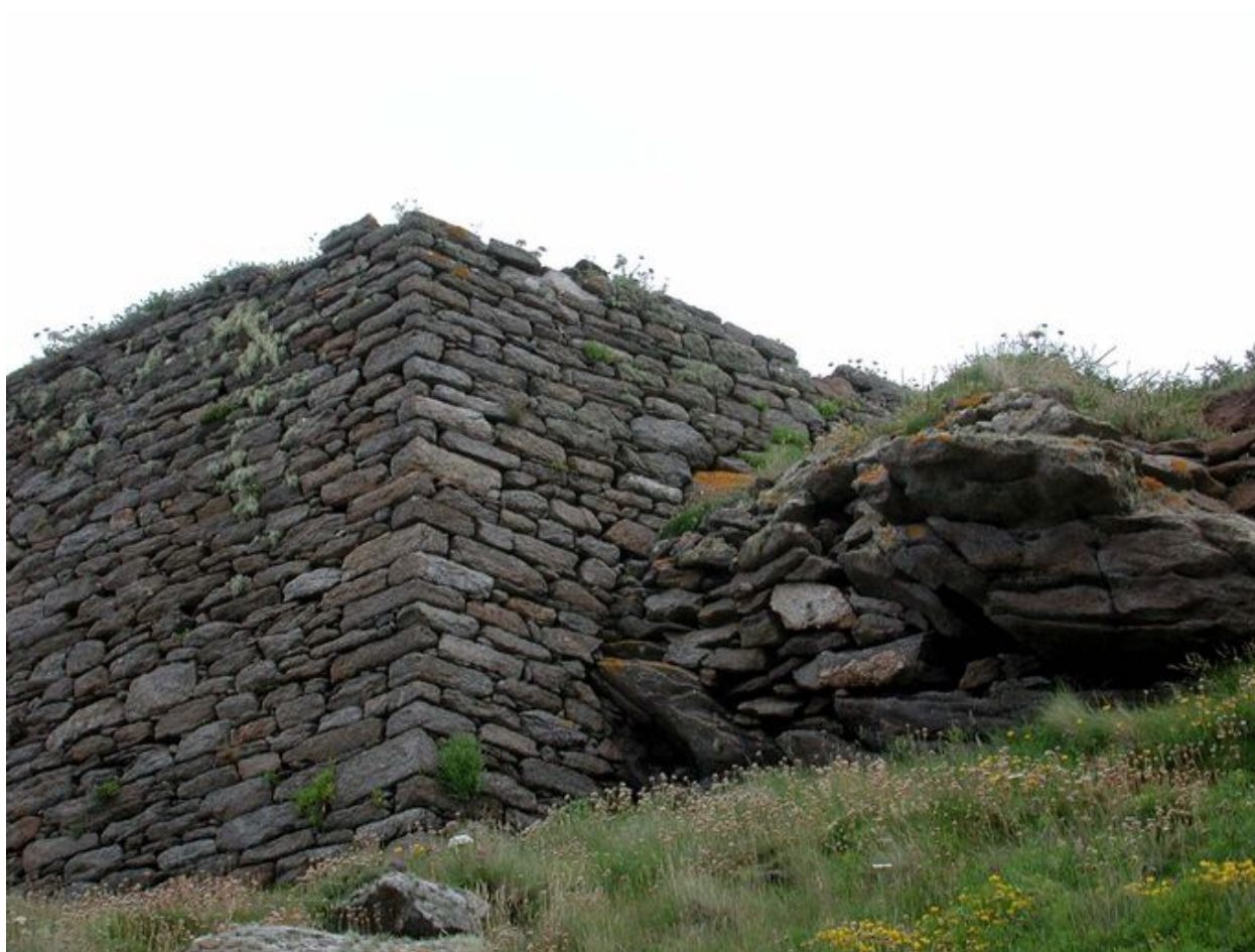
Vue de détail depuis l'ouest : liaisonnement du parapet avec le rocher (état en 2006)
