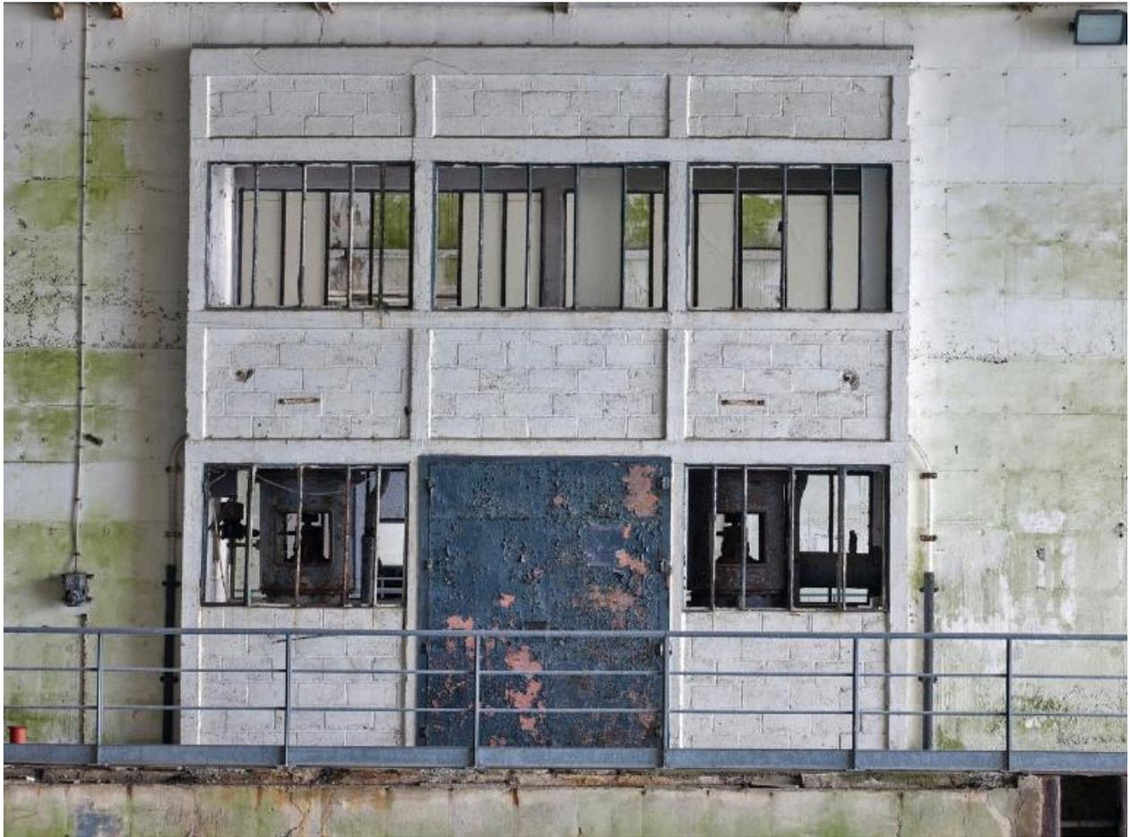
Vue de la salle des pompes aménagée dans l'épaisseur du mur de refend entre les alvéoles D et E. Au premier plan, le quai n° 19
