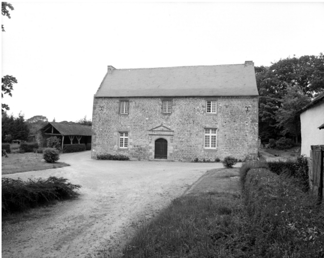
Façade antérieure, vue générale.
