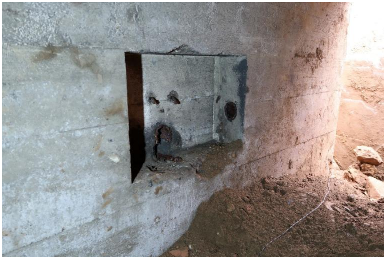
Vue du l'entrée nord : couloir d'accès flanqué par un créneau de tir, niche murale avec passage de câble
