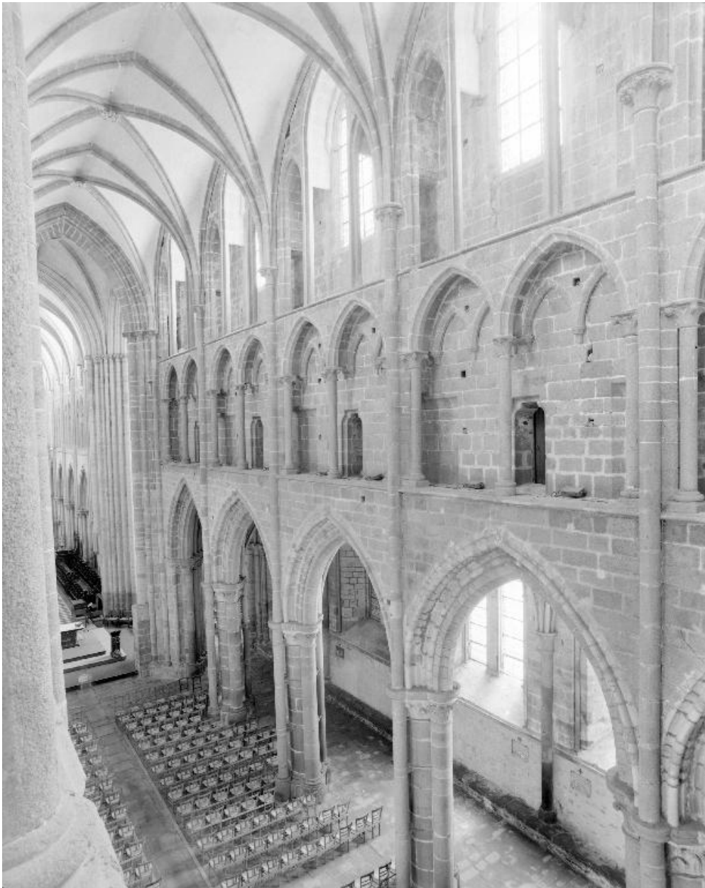
Intérieur, nef : élévation sud
