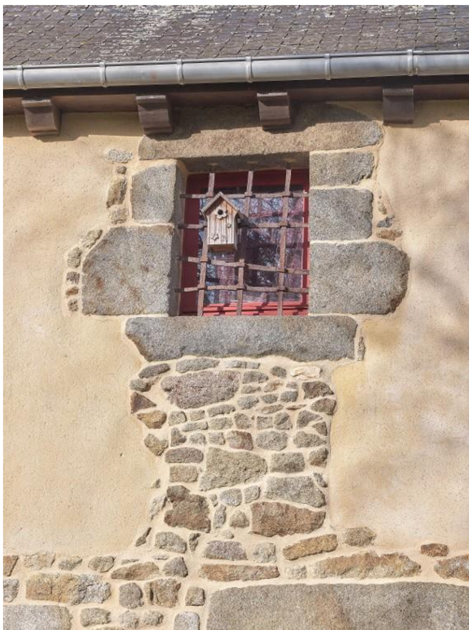
Façade sud. Fenêtre de la chambre haute protégée par une grille en fer forgé
