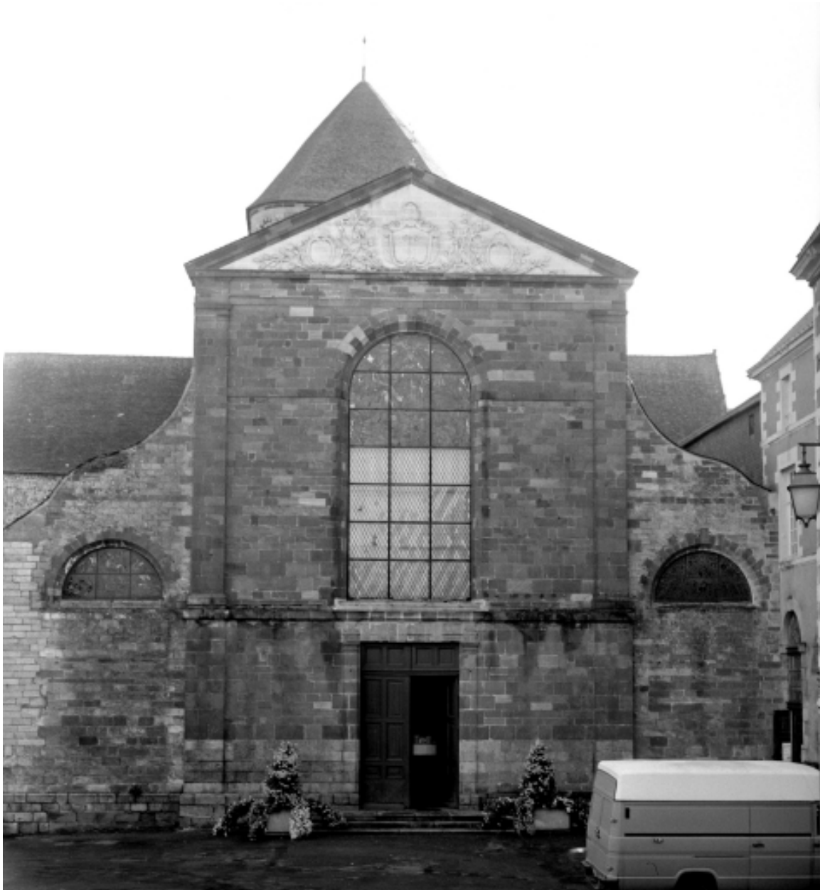
Elévation Ouest : vue générale
