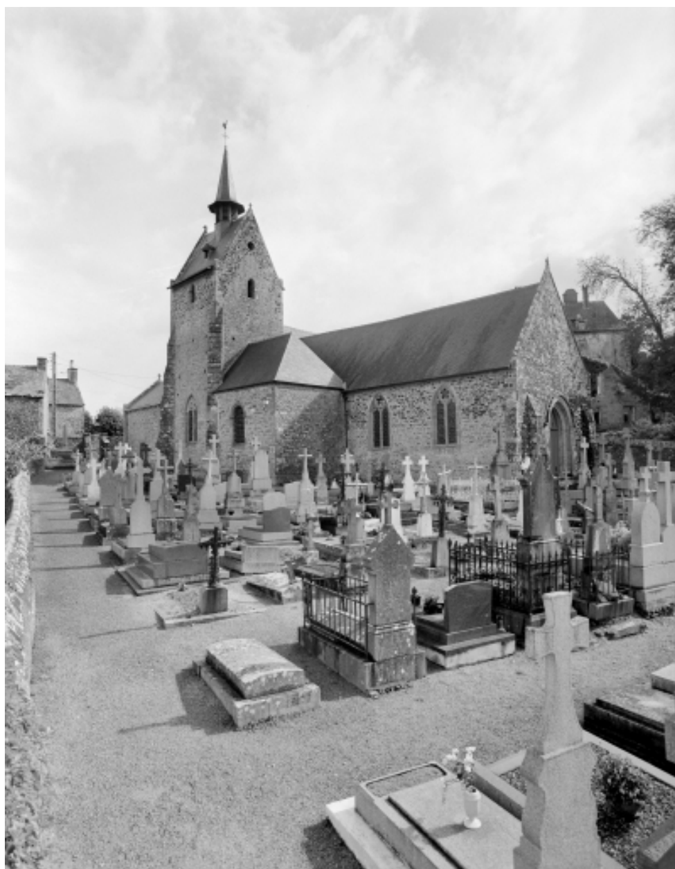
Elévation Nord-Ouest : vue générale
