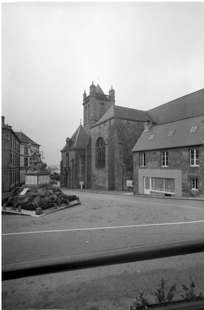
Vue de situation prise du sud est
