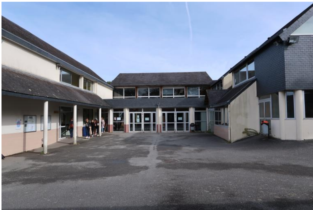
Préau, façade du hall et cour formée par les extensions postérieures au bâti d'origine.
