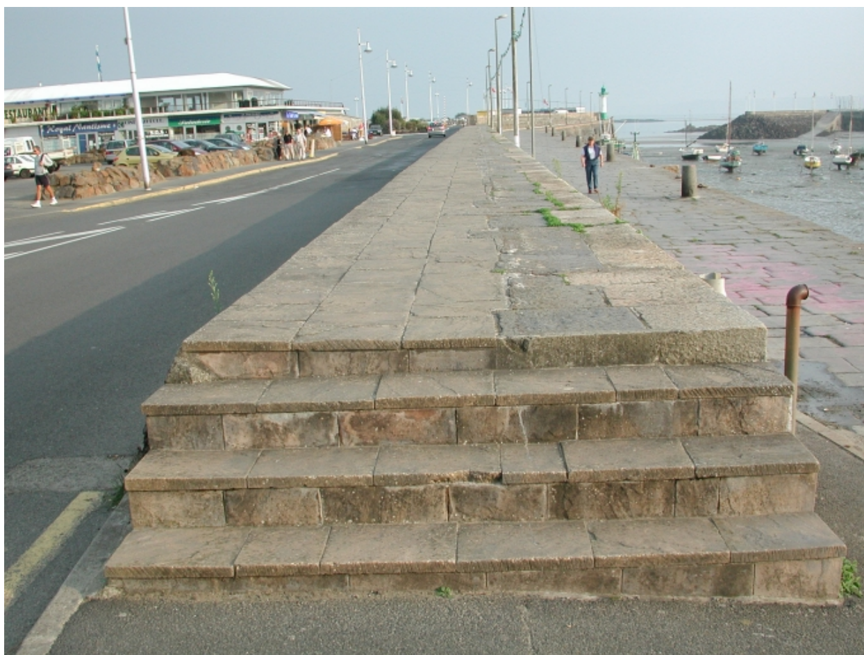
Vue générale du parapet
